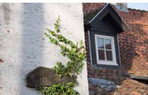
Cellulosevlokken op de kruipzolder.
