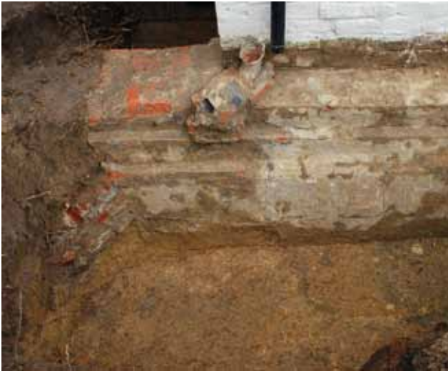
Fig. 2 De bijkomende funderingsconstructie aan de noordzijde van de pastorie te Meuzegem.
