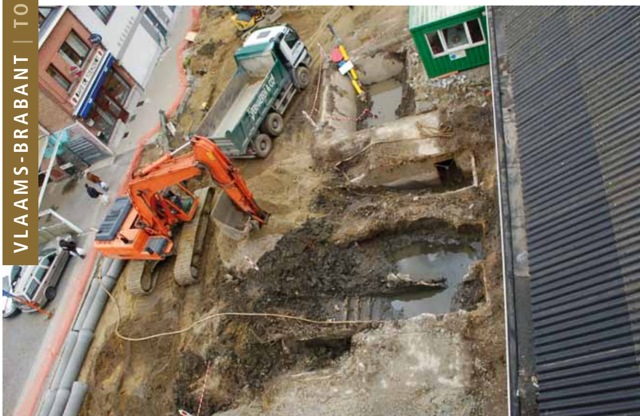
Fig. 1 Bovenaanzicht van de twee betonnen schuilkelders
