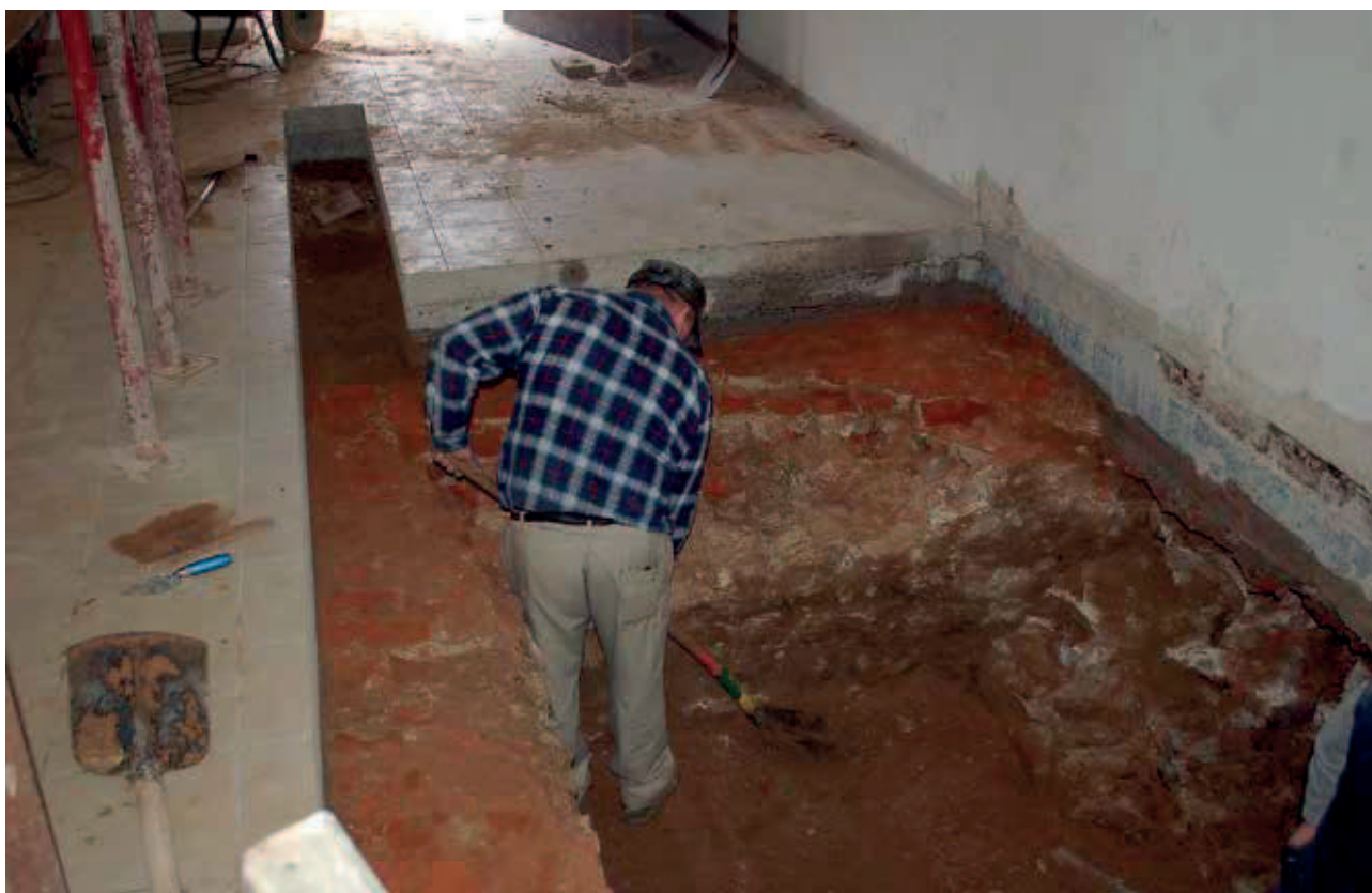
De liftkoker met de aangetroffen muren in het Tuchthuis van Vilvoorde
