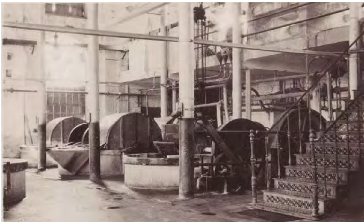
Zicht op de zaal waar de papierpap verder werd geraffineerd. Enkele houten beschermkappen boven de maalkuip zijn weggenomen. De oude gietijzeren trap verdween in 2012. De lange stalen pijlers maken de ruimte tot een 'kathedraal van de industrie'. Foto van rond 1910 uit het archief van de familie de Meurs, Brussel.
