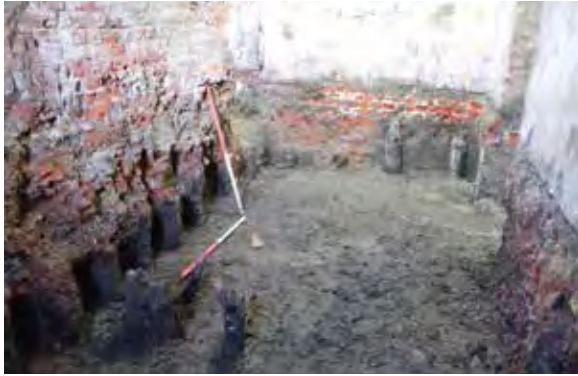
Houten funderingspalen.
