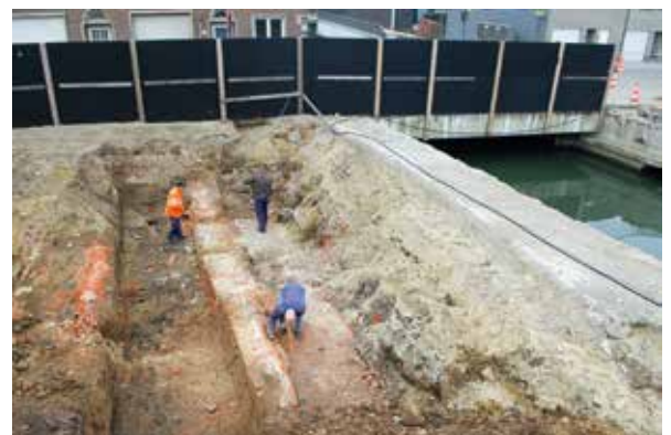
Het opschonen van muurfunderingen naast de Dijle aan de Mechelsestraat te Leuven.
