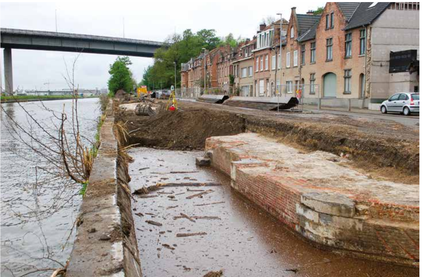
Detail van de zuidelijke sluismuur langs de Brusselsesteenweg te Vilvoorde.
