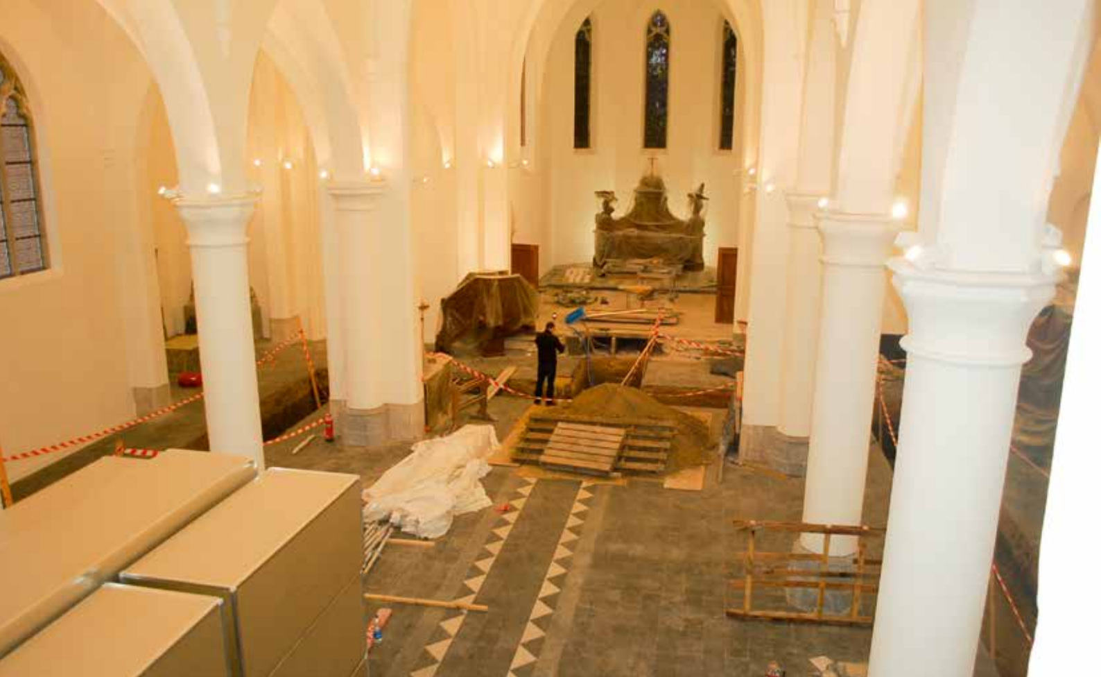
Zicht op de werkzaamheden in de Sint-Hubertuskerk.
