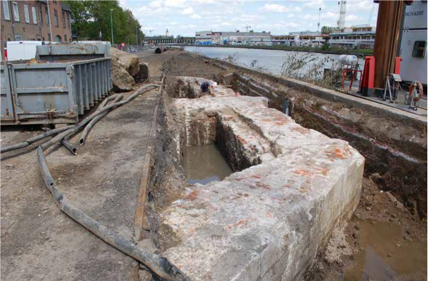
De noordelijke sluismuur langs de Brusselsesteenweg te Vilvoorde.
