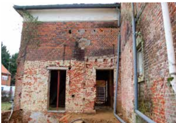
› De lijnen van de twee daken van de aanbouwen tegen het poortgebouw.
