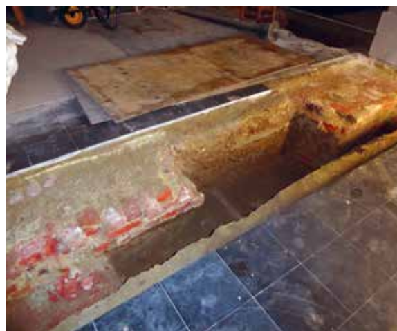
› Bakstenen funderingen in sleuf 5 (Leuven - Sint-Michielskerk).
