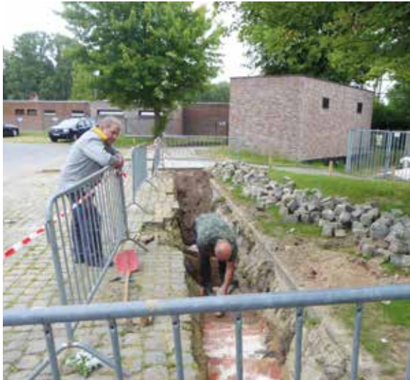
› De rioleringsleuf met bakstenen constructies te Wilsele.
