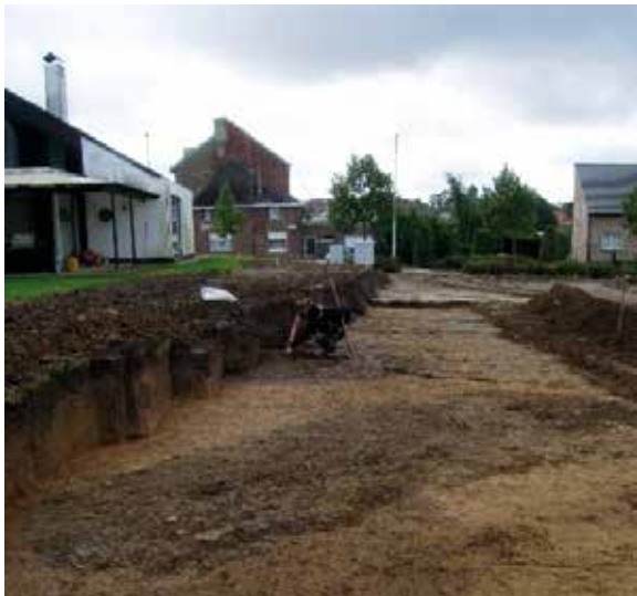
› Op het afgegraven terrein te Asse tekenden zich enkele grote kuilen af.
