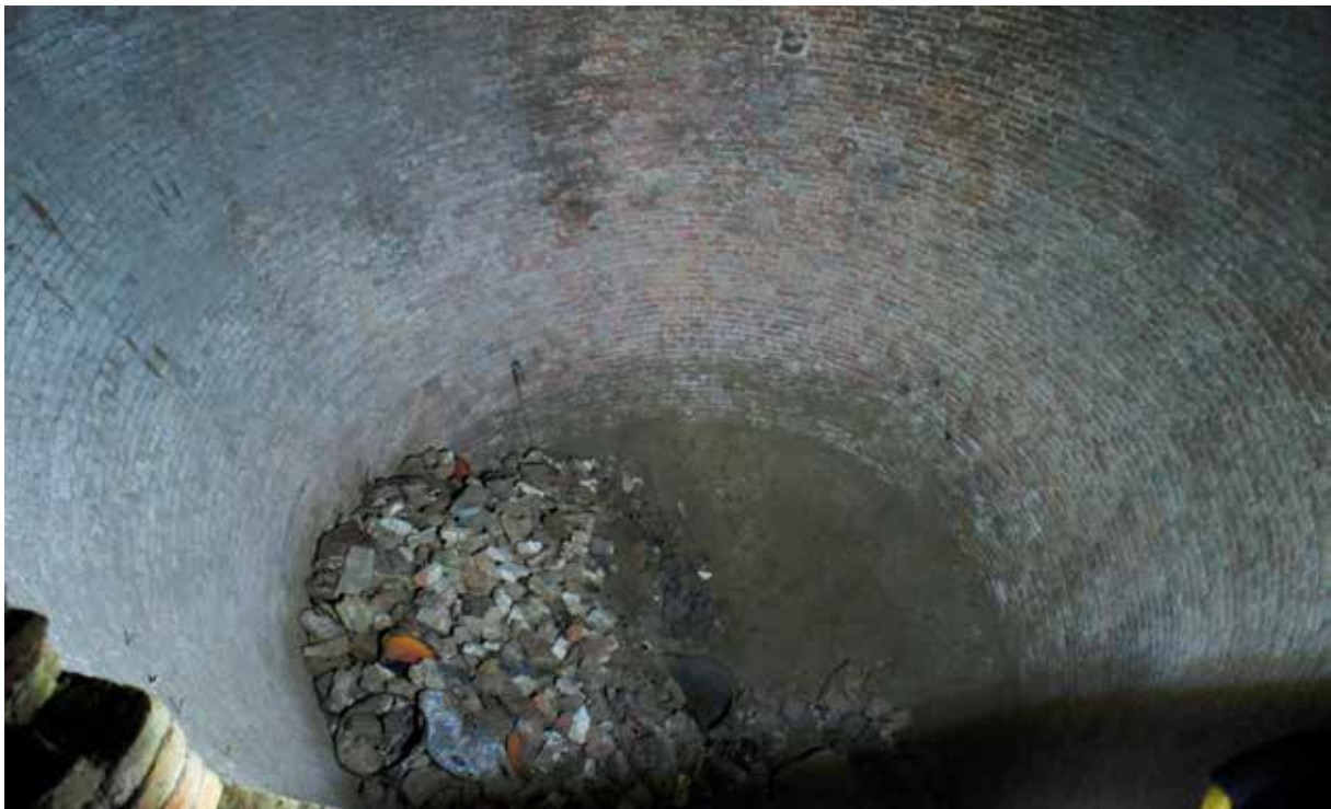
› Grote brokstukken konden helaas niet opgezogen worden, waardoor er nog een aanzienlijke hoeveelheid puin achterbleef maar de bodem (incl. drainagekanaal) wel al zichtbaar gemaakt kon worden.
