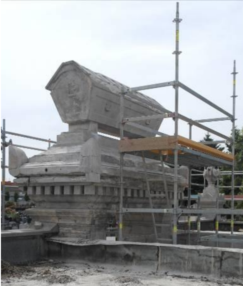
Zicht op de bekronende sarcofaag bovenop de inkom van het galerijencomplex. Deze hele constructie (1880) is integraal uitgevoerd in beton. Foto Tom Verhofstadt (26 juni 2015)
