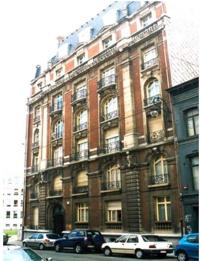
Charleroisesteenweg 70, Binnenin is een originele Otis-lift bewaard die in 2021 is beschermd.
