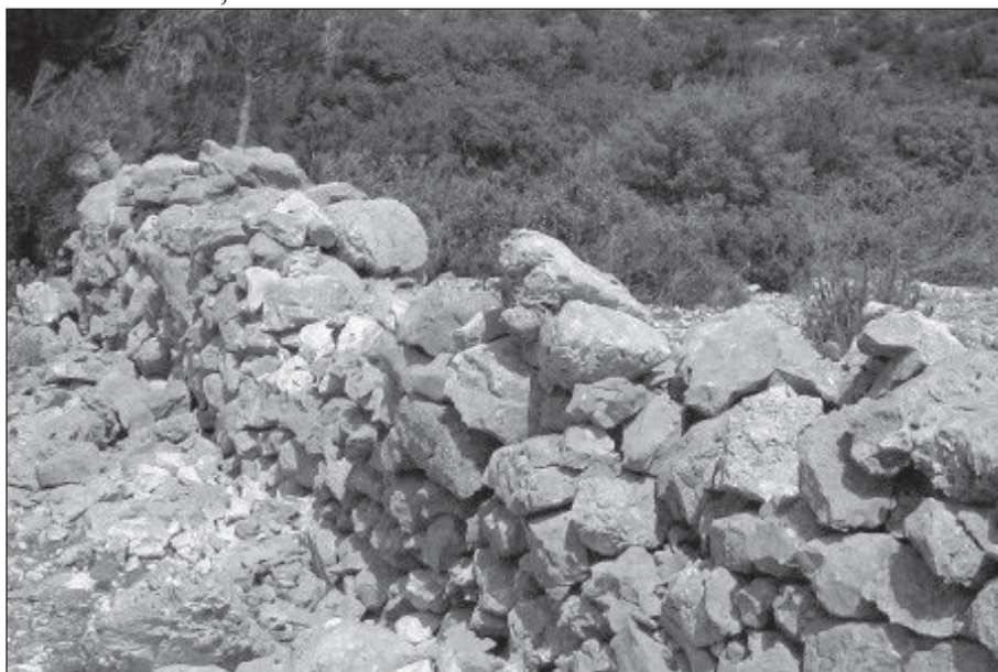
Un tronçon du Mur de Peste (Provence).
