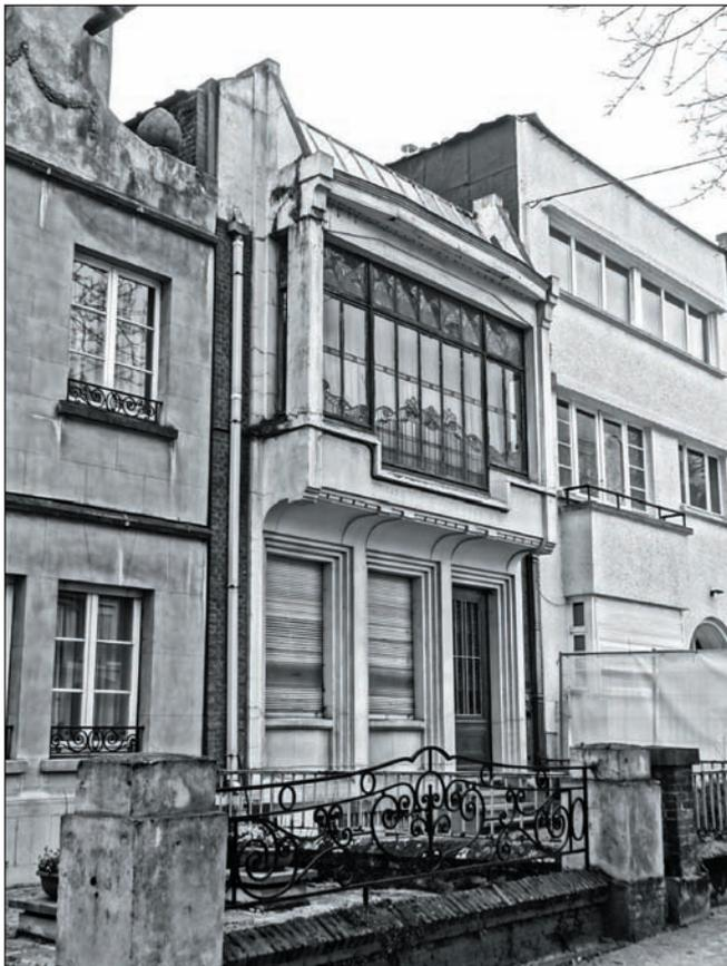
*La façade avant vue de côté. La verrière s'encastre dans la maçonnerie.*
