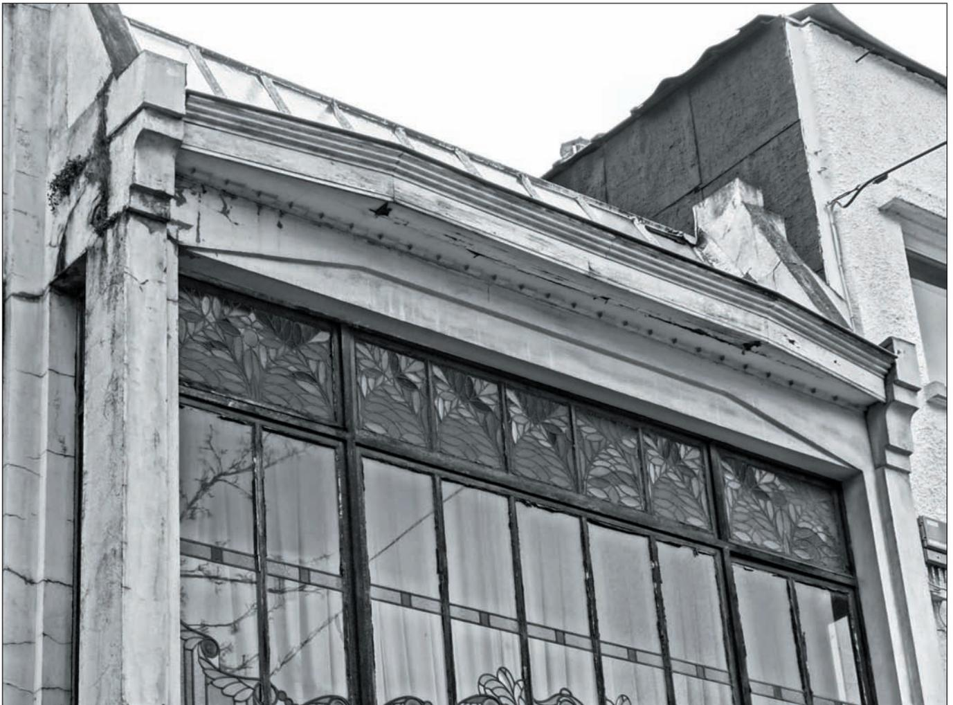
*La corniche trapézoïdale. Le trapèze de la corniche est repris en creux à l'emplacement de la frise.*
