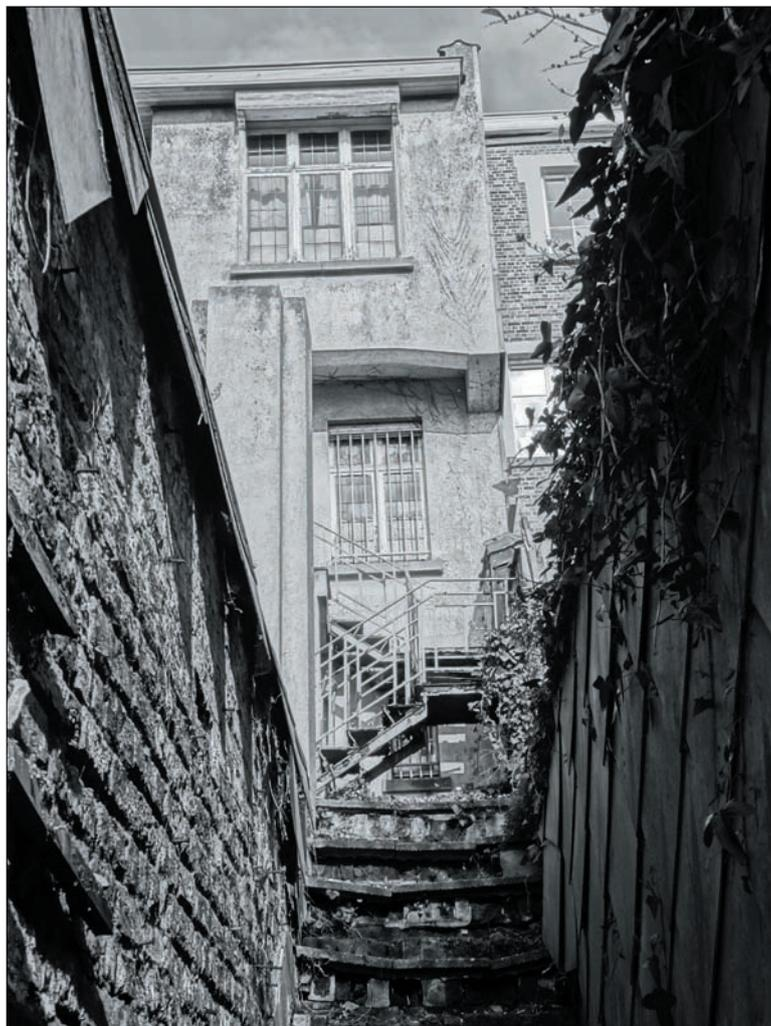
*La façade arrière, vue d'en bas : le bow-window, l'escalier métallique, l'escalier d'accès au garage et l'un des pilastres en maçonnerie.*
