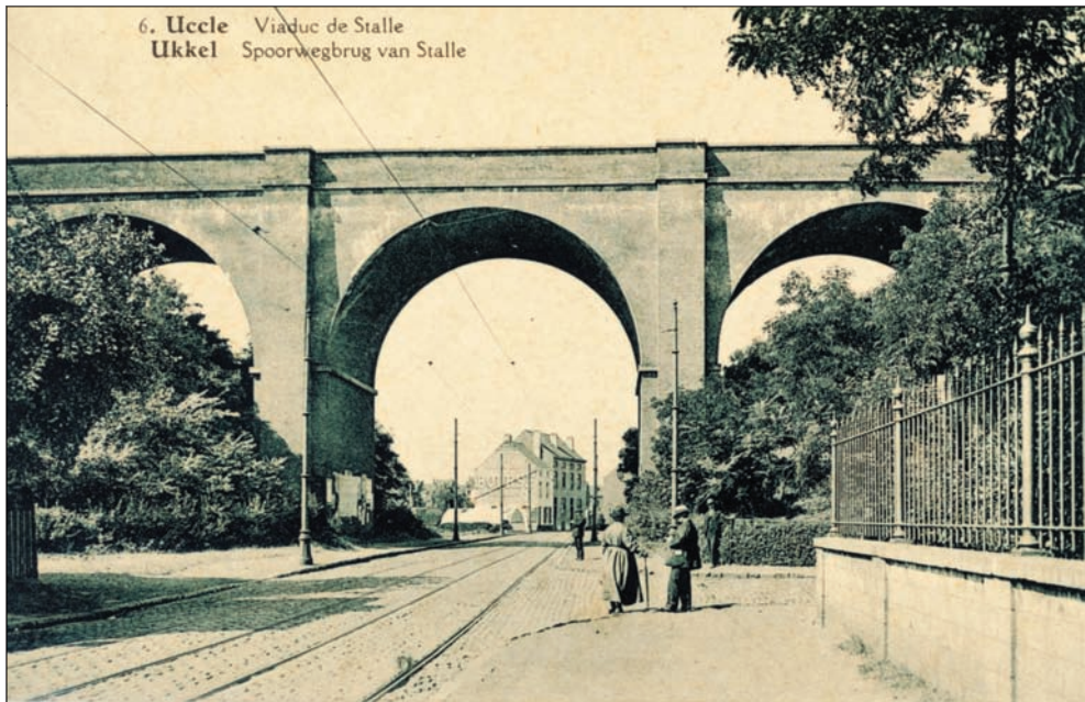
Le viaduc de Stalle (vu en venant du centre d'Uccle vers Neerstalle) et le mur entourant l'ancienne propriété Allard.
