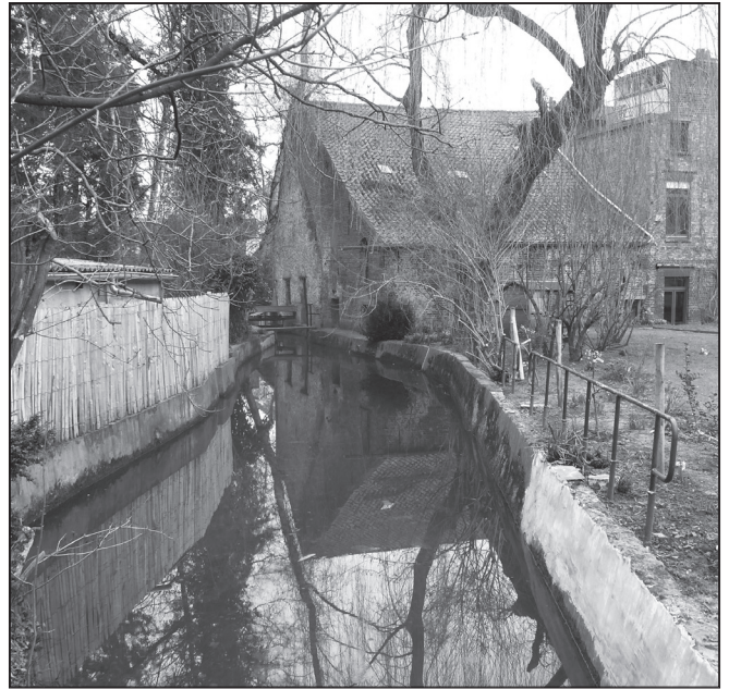
Le bief d'amenée d'eau au moulin.
