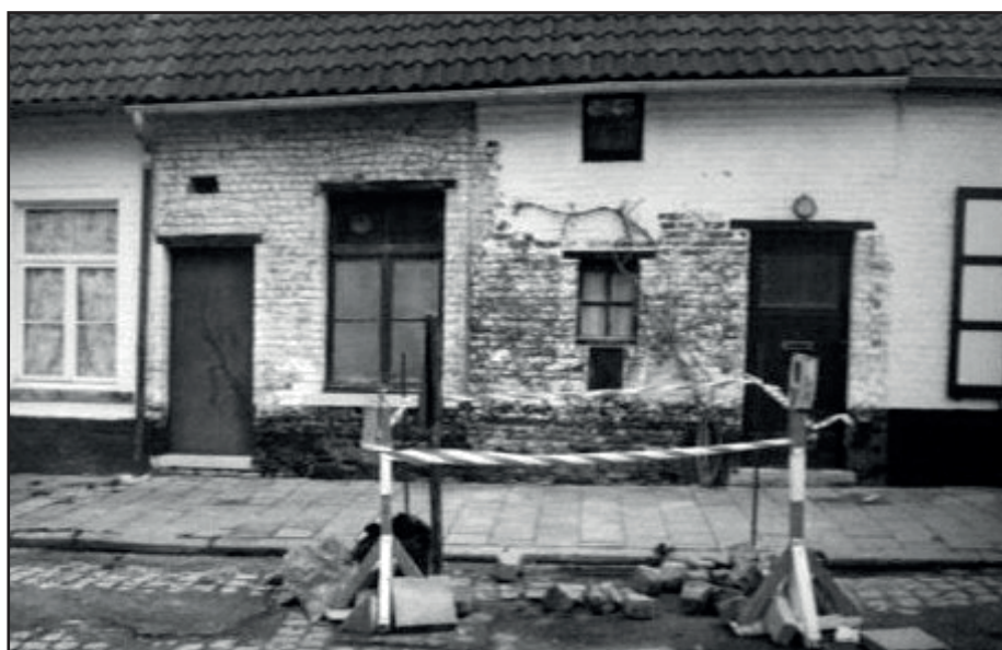
Façade du n° 8 de la rue Geleytbeek. Le décrochement divisant la façade est très visible sur la photo (1995, collection de la propriétaire).
