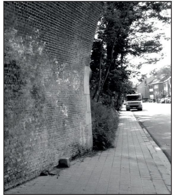
Pavé hectométrique 5 sous le viaduc du chemin de fer, près de l'avenue Dolez (vue générale) (cliché AP)
