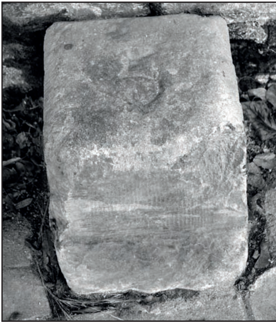
Pavé hectométrique 5 sous le viaduc du chemin de fer, près de l'avenue Dolez (vue rapprochée) (cliché ME déc. 2020).
