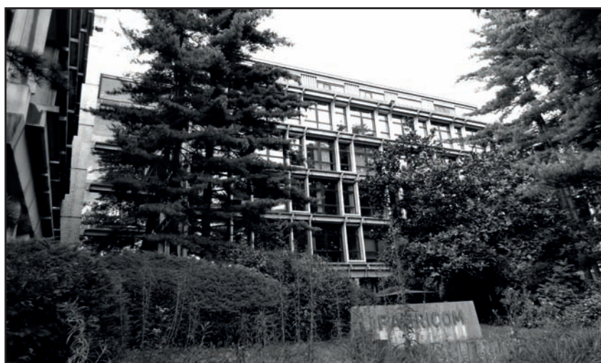
L'immeuble « Fabricom » avant sa rénovation et sa conversion en centre administratif.
