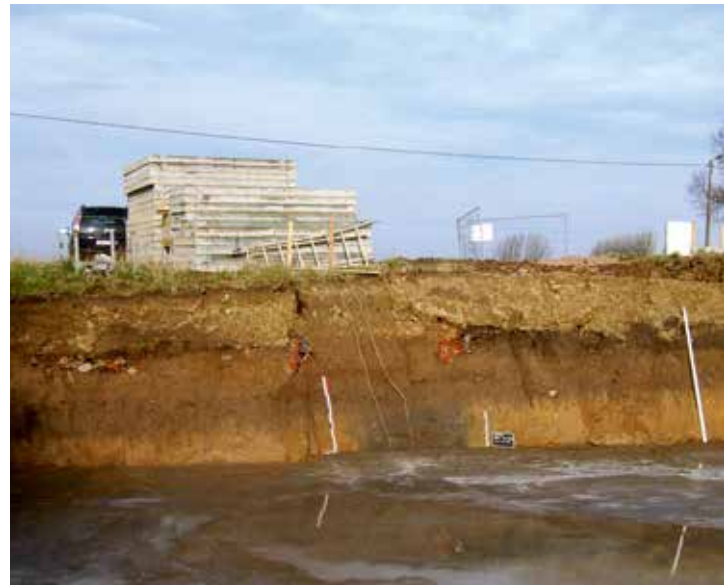
Kester-Edingsesteenweg. Zicht op de bouwput en het geregistreerde westprofiel.
