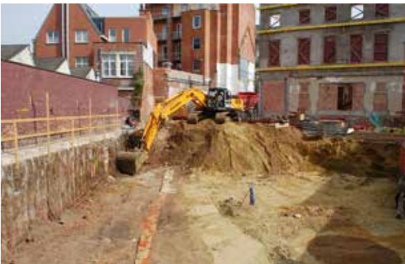
De uitgravingen op het terrein aan de Naamsestraat te Leuven.
