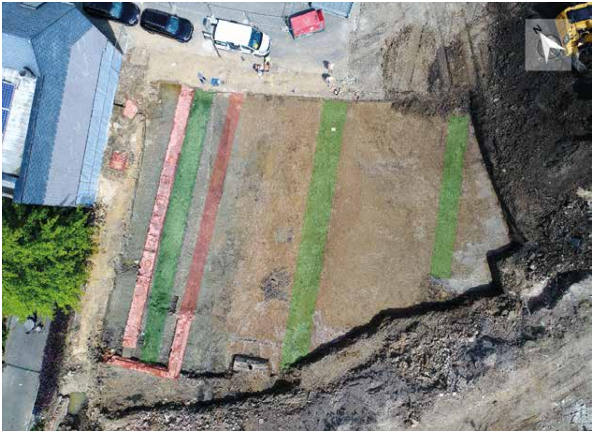
Oostelijk deel van het projectgebied met muurfunderingen van de brouwerij (rood); (beschoeide) greppels (groen) en het blauwgrijze ophogingspakket vermoedelijk om de Zenne in te dijken
