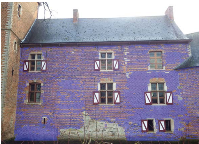
De verblauwingstechniek toegepast op de noordgevel van het woonhuis. In één oogopslag zijn de grote kopse zones zichtbaar, in dit geval te linken aan de 17de-eeuwse verbouwingfase. Het linkerdeel is 15de-eeuws. (Ferre O)
