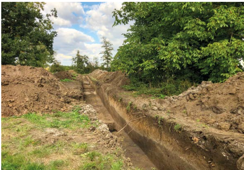
Ravelijn: aanleg proefsleuf dwars over ravelijn en voorwerken.
