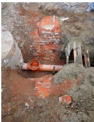
◀ De bakstenen fundering met in profiel het verschil in de gebruikte mortels bovenaan en onderaan. © stad Leuven, Lisa Van Ransbeeck
