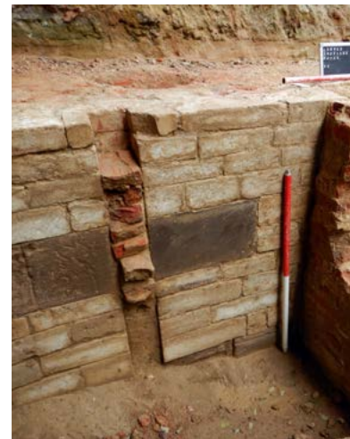
▲ Detail van de plaats van het valhek, nu opgevuld met enkele bakstenen en grond en een muur om de poort te versmallen. © stad Leuven
